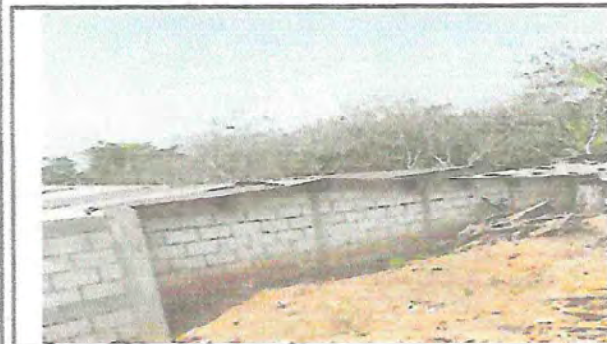
Foto 3: area desolada para bocontinuar el muro perietral.
